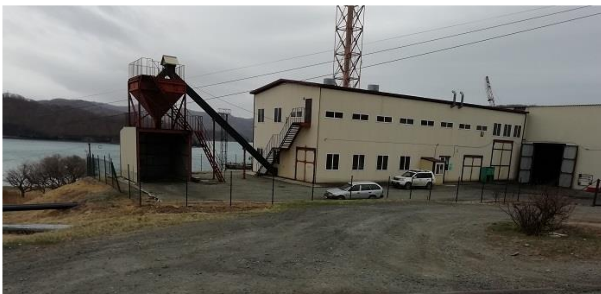
Рисунок 4. Внешний вид котельной №4 п. Подьяпольское
