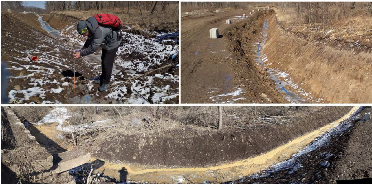
Рис.4.6. Канава МВС-1, разработанная вдоль верхового откоса старой автодороги от тальвега ручья 5 до впадения в ручей 1. Вверху слева – начало канавы у ручья 5, вверху справа – на участке между ручьями 2 и 3, внизу – соединение с ручьем 1
