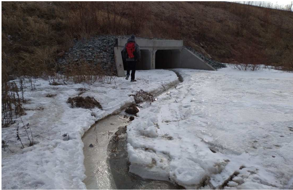
Рис.4.24. Ручей 9 у водопропускного отверстия с верховой стороны насыпи на ПК171+79
