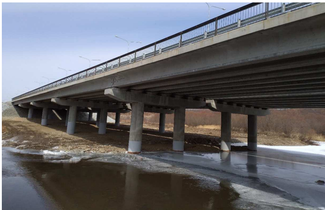
Рис.4.26. Мостовой переход через реку Суходол, вид с левого берега
