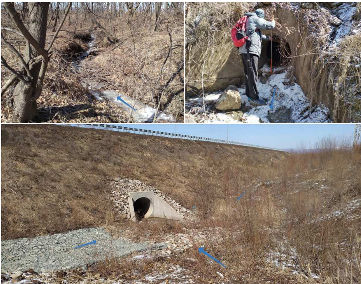
Рис.4.15. Ручей 6. Вверху слева – врез водотока, вверху справа – труба 1,0 м через старую грунтовую автодорогу, внизу – труба диаметром 1,5 через а/д «Владивосток-Находка...» на ПК112+17
