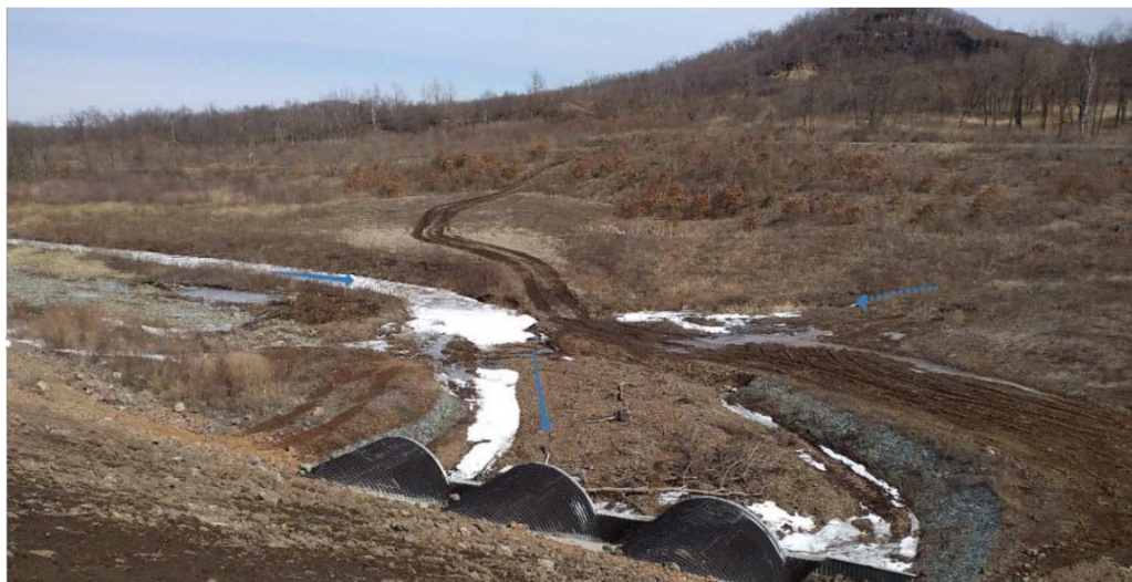
Рис.4.20. Ручей 8 у входного отверстия конструкции водопропускного сооружения на ПК134+23, справа впадает приток ручья 8 - ручей 8а
