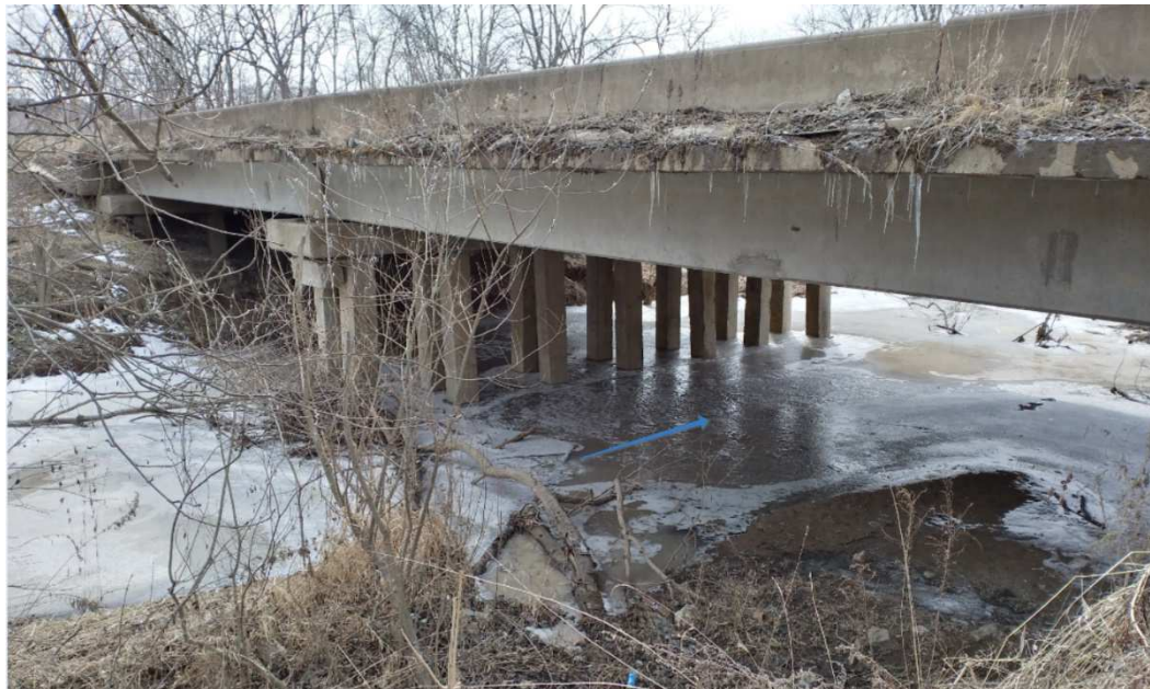
Рис.4.18. Мостовой переход по грунтовой автодороге через ручей 8 (расчетный створ 8.1)
