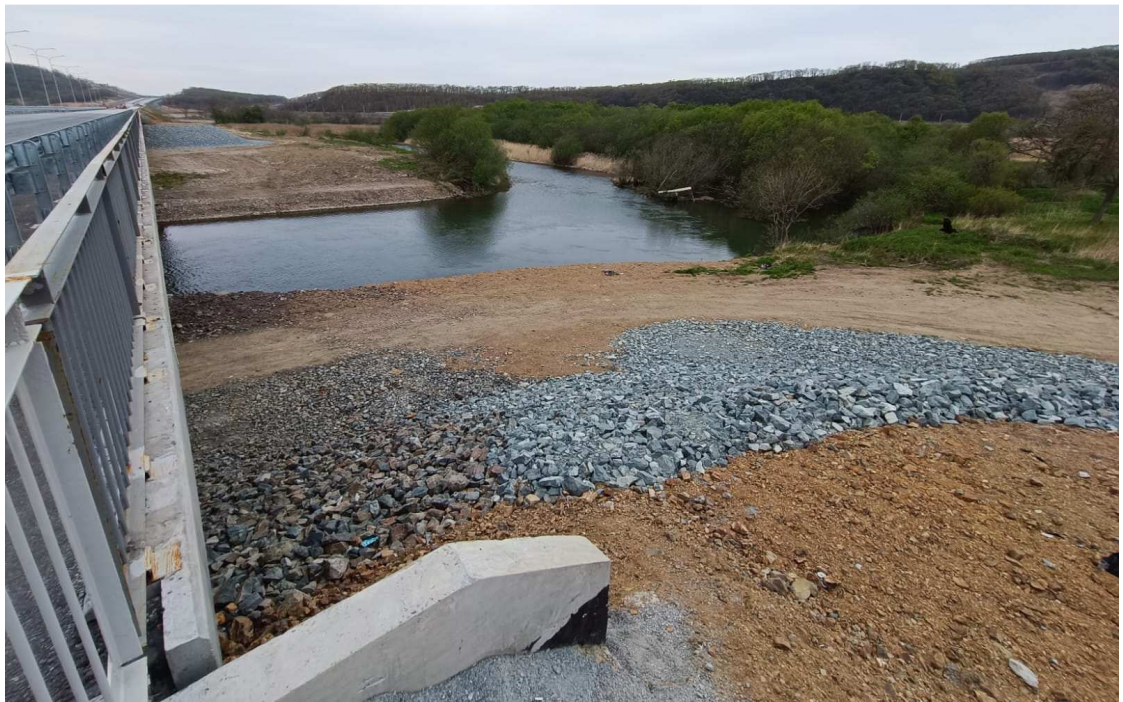
Рис. 4.27. Река Суходол выше мостового перехода на ПК 178+04, вид с левого берега
