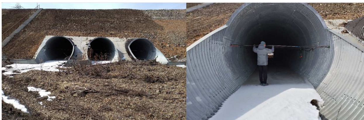
Рис. 4.19. Водопропускное сооружение через а/д «Владивосток-Находка-порт Восточный» на ПК 134+23 (расчетный створ 8)
