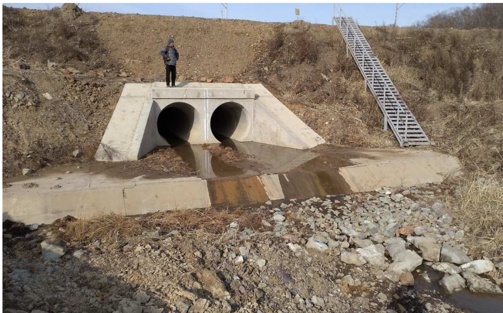
Рис. 4.22. Водопроепное сооружеие на ручье 9 через грунтоую автодорогу напротив ПК168+30 а/д «Владивосток-Находка...»
