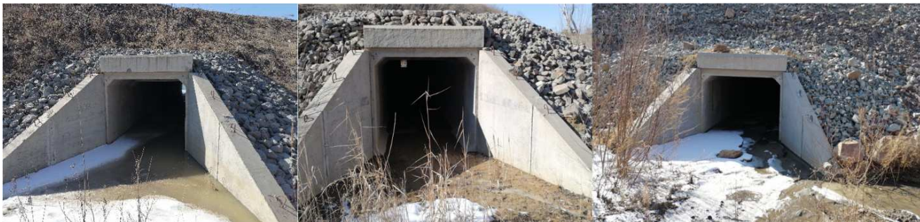
Рис 4.10. Водопропускные отверстия через а/д: слева - на ручье 2 (ПК102+56), в центре - на ручье 3 (ПК105+20) и справа - на ручье 5 (ПК105+20)
