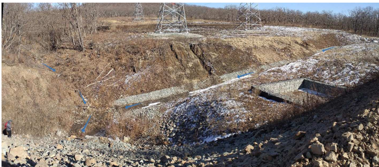
Рис.4.13. Долина ручья 5 (слева) и канализированное русло, габион (правее), у верхового откоса перед «уходом» стока в водопропуск
